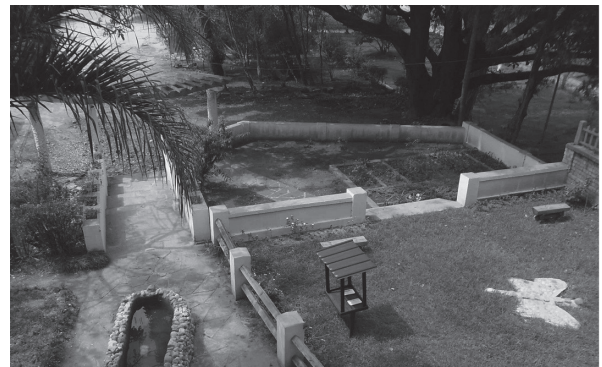
図 18. 基礎工事が完了したバタフライガーデン
