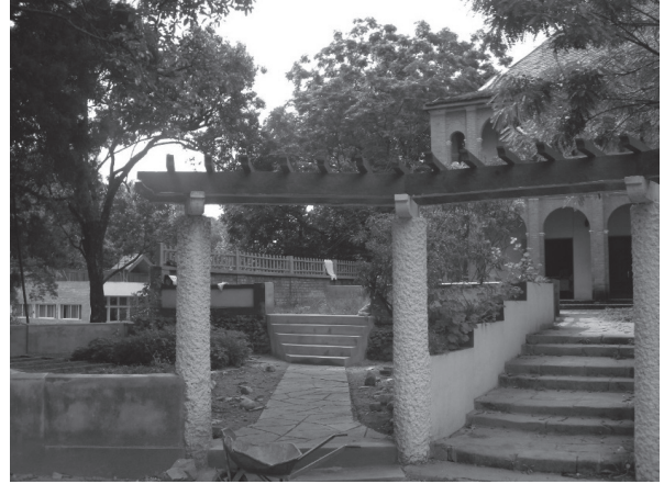
図 14. 建設中のバタフライガーデン
