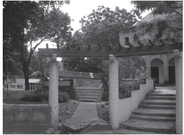
図 14. 建設中のバタフライガーデン
