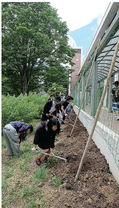
図14. グリーンカーテンの設置
