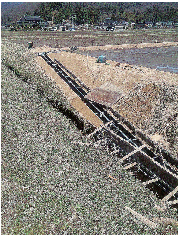
図4. コウノトリの郷公園周辺に見られる、環境に配慮した田圃(手前に見えるのは、水生生物を田圃に遡上させるための新規工事中の魚道)。
