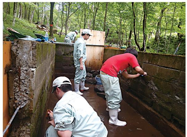
図4. 壊れた養殖場の壁の補修作業
