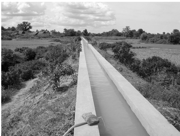
図5 ポンプでため池から汲み上げた水を用水路に流す
